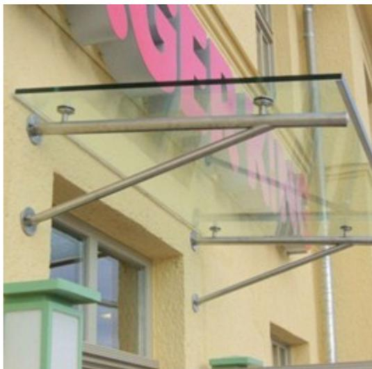
Beim Vordachsystem Bajo wird das Glas von unten befestigt. Die Glasscheibe wird mit Glashaltern auf robusten einzelnen Rohrträgern bzw. einem durchgehenden Rohrrahmen fixiert. Dadurch kann das Vordach dicht an der Haustür montiert werden und bietet sich für beengte Platzverhältnisse an. Regenschutz ist somit schon bei geringer Dachausladung geboten.
