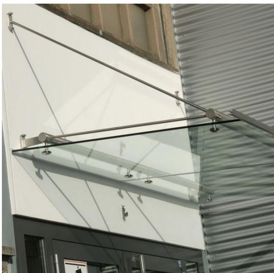
Speziell für große Vordächer bietet sich das System Forte an. Ein Rohrrahmen aus hochwertigem Edelstahl wird wandseitig mit Edelstahl-Zugstreben befestigt. Die Vordachabhangung erlaubt eine Dachtiefe bis zu 200 cm. Das Glas wird mit Glashaltern fest am Rohrrahmen verschraubt. Fur daruber hinaus gehende Uberdachungen erarbeiten wir in unserer Konstruktionsabteilung Speziallosungen, die zusatzliche Stutzpfosten oder Sonderbefestigungen vorsehen.
